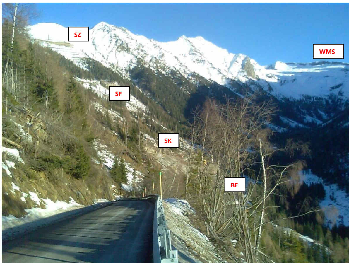
Abb. 1: Blick in den Mühldorfer Graben mit Baustelleneinrichtung (BE), Stollenmundloch für Kavernenkraftstation (SK), Fensterstollen und Zugangsstollen Schoberboden II (SZ) und Wasserspeicher Großer Mühldorfer See (WMS).
