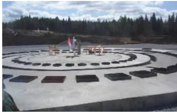
Abbildung 2: 17.08.2010: Fertigstellung der Bohrplatte
