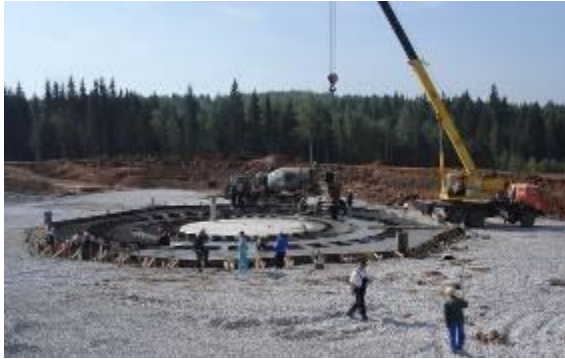
Abbildung 3: 16.08.2010: Herstellen der Bohrplatte
