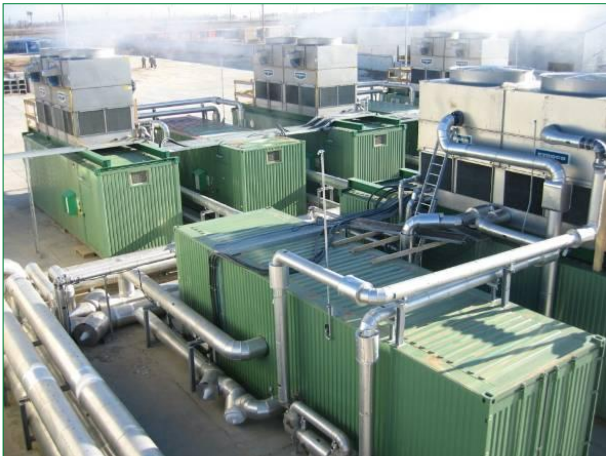
Рис. 1: Замораживающая станция Тиссен Шахтбау
