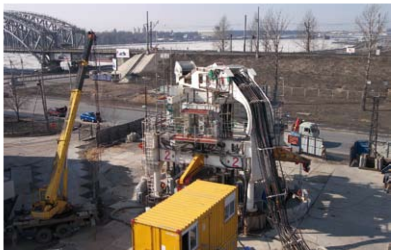
Рис. 7. Строительная площадка «Санкт-Петербург» – общий вид установки для бурения шахтных стволов
