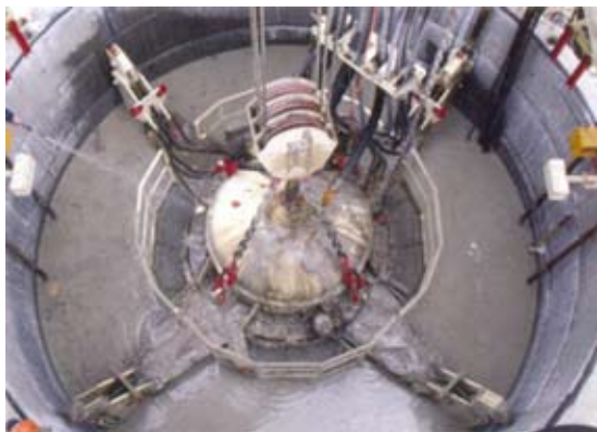
Рис. 8. Строительная площадка «Санкт-Петербург» – извлечение машины по завершении строительства шахтного ствола
