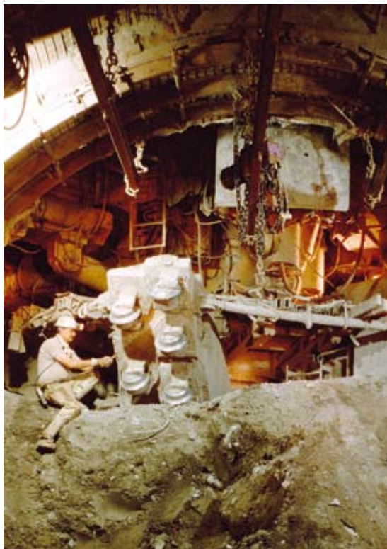
Рис. 3. Сбойка ствола, пробуренного по технологии «V-Mole»
