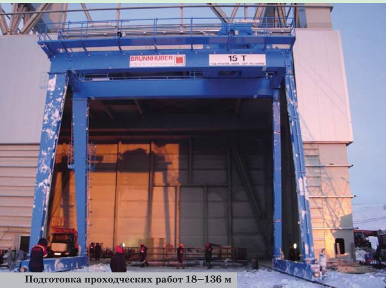
Работы, осложненные морозами
