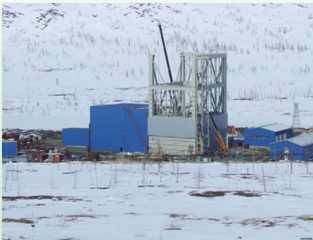
Стройплощадка ВС-10. Слева направо: строящаяся ГПП-70, шлюз, пристволовой склад, копер, здание проходческих вентиляторов, административно-бытовой комплекс, склад материалов, станция очистки сточных вод
